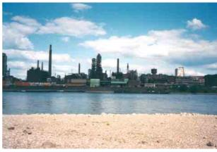
Bild 16: Verbaute Ufer wie hier bei Leverkusen unterbinden eine Lateralerosion des Stromes vollständig.
