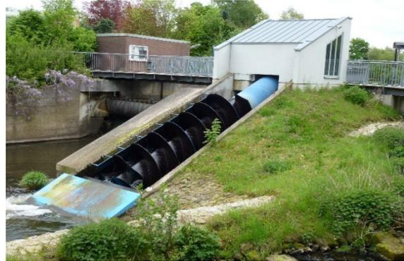
Wasserkraftanlage mit Wasserkraftschnecke
