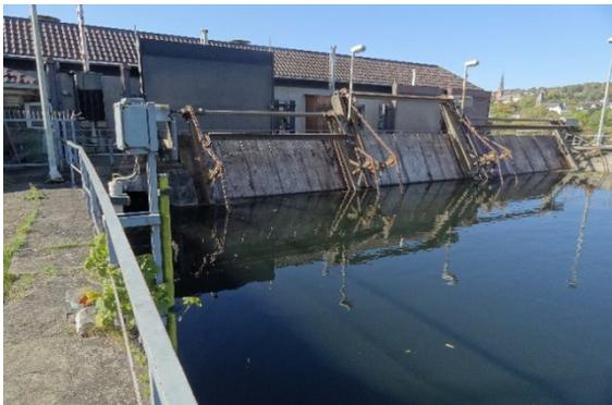
Wasserkraftanlage mit vorgeschalteter Rechenanlage
