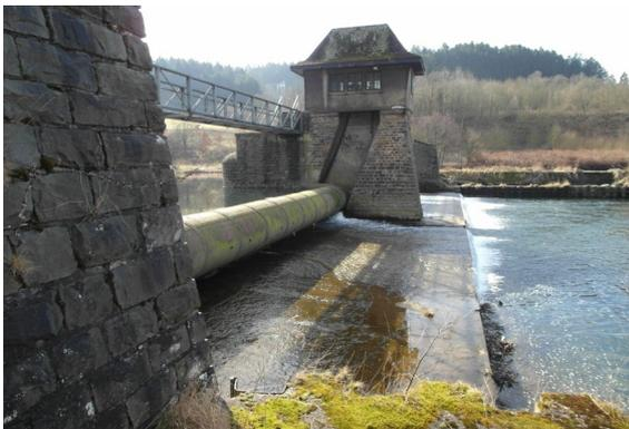
minimale Wasserspiegeldifferenz entspricht Sockelhöhe
