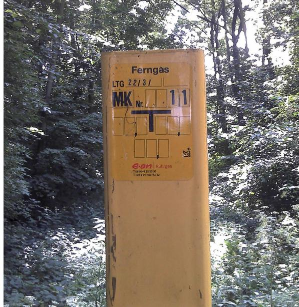
Hinweisschilder markieren unterirdisch verlaufende Rohrfernleitungen. Hier sind zuverlässige Leckerkennungssysteme besonders wichtig.
