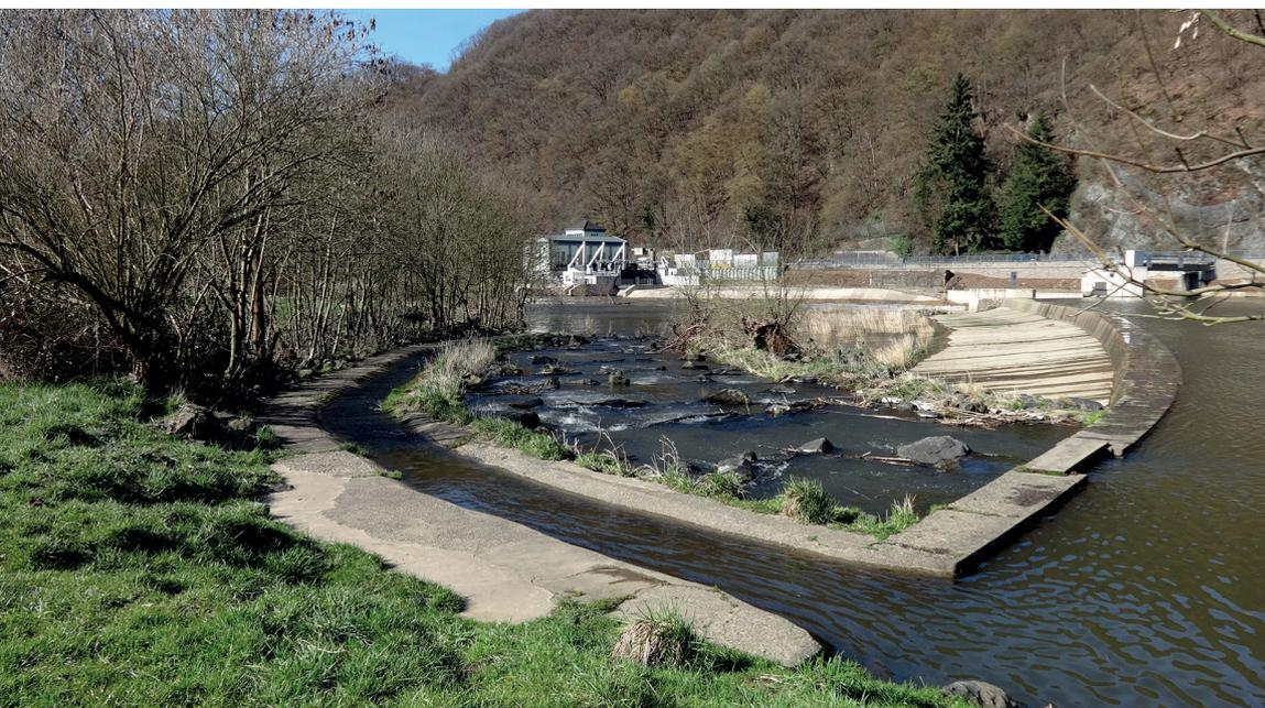
Das Wehr Unkelmühle wurde aufwändig umgebaut und eine Pilotanlage für den Fischschutz errichtet (links: Bootsrutsche, Mitte: Fischtreppe, rechts: Wehr, Hintergrund: Wasserkraftanlagen)
