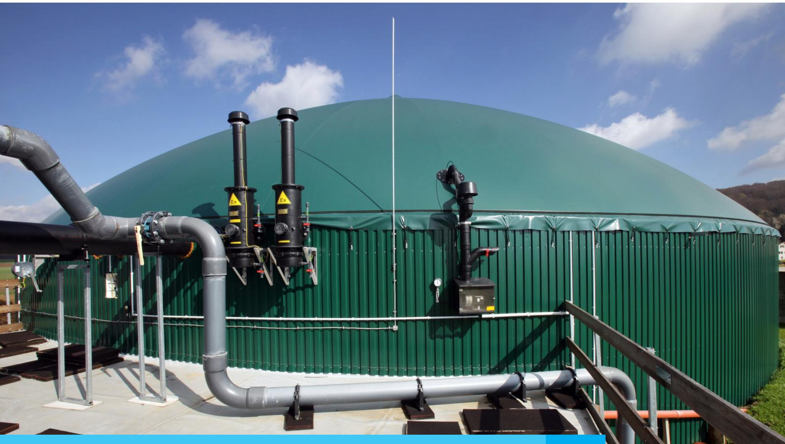
Das erzeugte Biogas wird zumeist in Blockheizkraftwerken eingesetzt, um Strom zu erzeugen. Die Abwärme wird in der Regel zum Heizen oder zum Trocknen zum Beispiel von Hackschnitzeln genutzt. Darüber hinaus kann das Methangas in einer nachgeschalteten Aufbereitungsanlage separiert und in ein nahegelegenes Erdgasnetz eingespeist werden.
