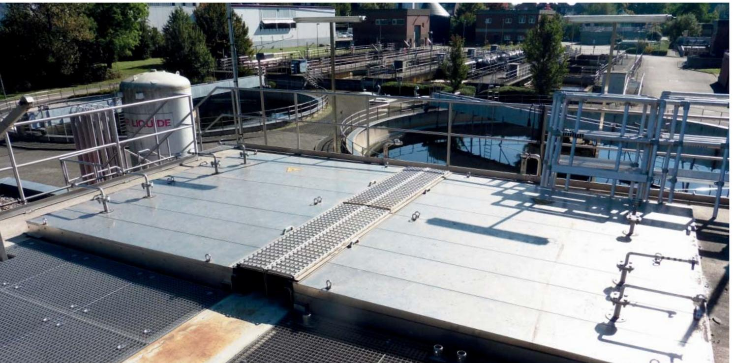
Das Abwasser wird auf der Kläranlage Duisburg-Vierlinden mit Ozon behandelt (abgedeckter Bereich im Vordergrund), um Mikroverunreinigungen zu eliminieren. Viele weitere Kläranlagen sollen in Zukunft eine 4. Reinigungsstufe erhalten.
