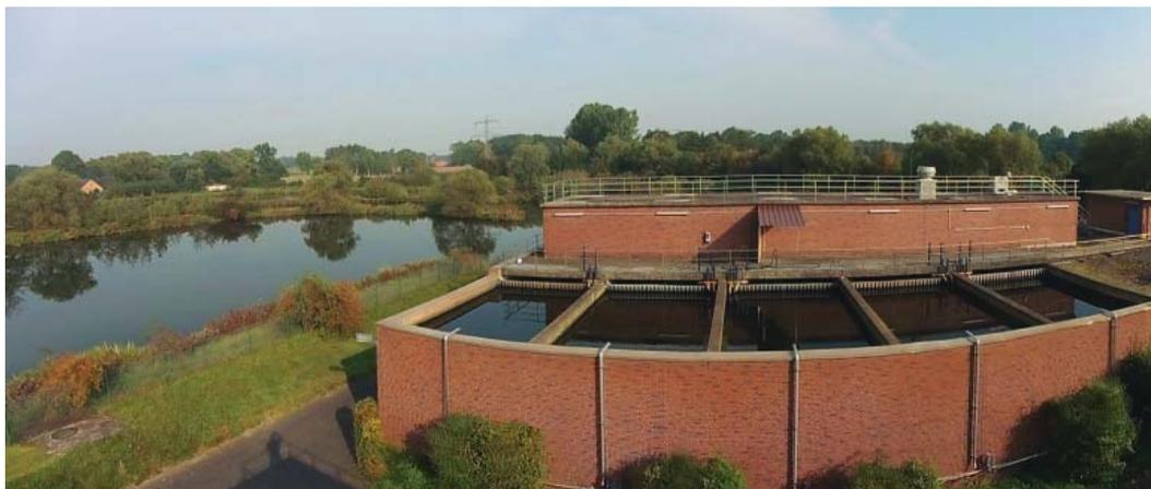
Die Kläranlage des Abwasserverbandes Obere Lutter verfügt als 4. Reinigungsstufe über eine Granulierte Aktivkohleanlage. Die gereinigten Abwässer werden anschließend in Schönungs- teiche eingeleitet (links im Bild).
