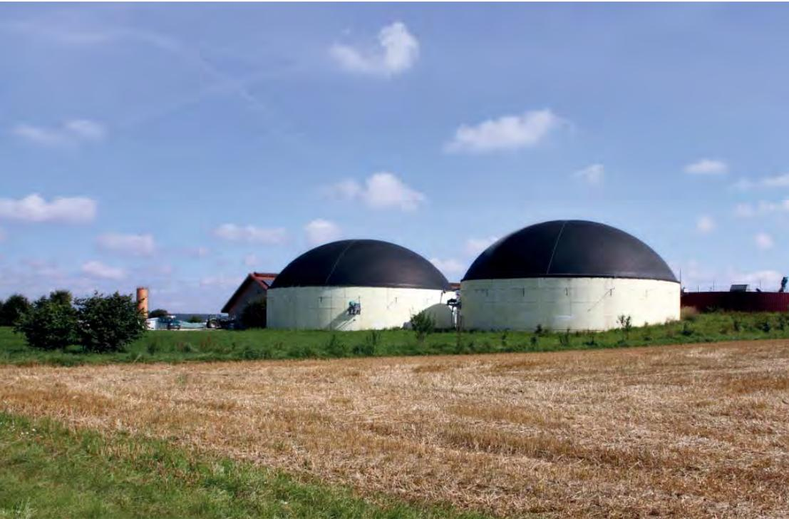
Landwirtschaftliche Biogasanlage: Die Vergärung von Gülle in einer Biogasanlage verändert nicht die darin enthaltene Stickstoffmenge. Biogasanlagen können dennoch zu einer Verschärfung der Nährstoff-Situation beitragen, wenn sie in Gebieten mit intensiver Tierhaltung liegen und neben Gülle viel pflanzliche Rohstoffe (z. B. Mais) verarbeiten. Dadurch entstehen zusätzliche Mengen von stickstoffhaltigen Gärresten.
