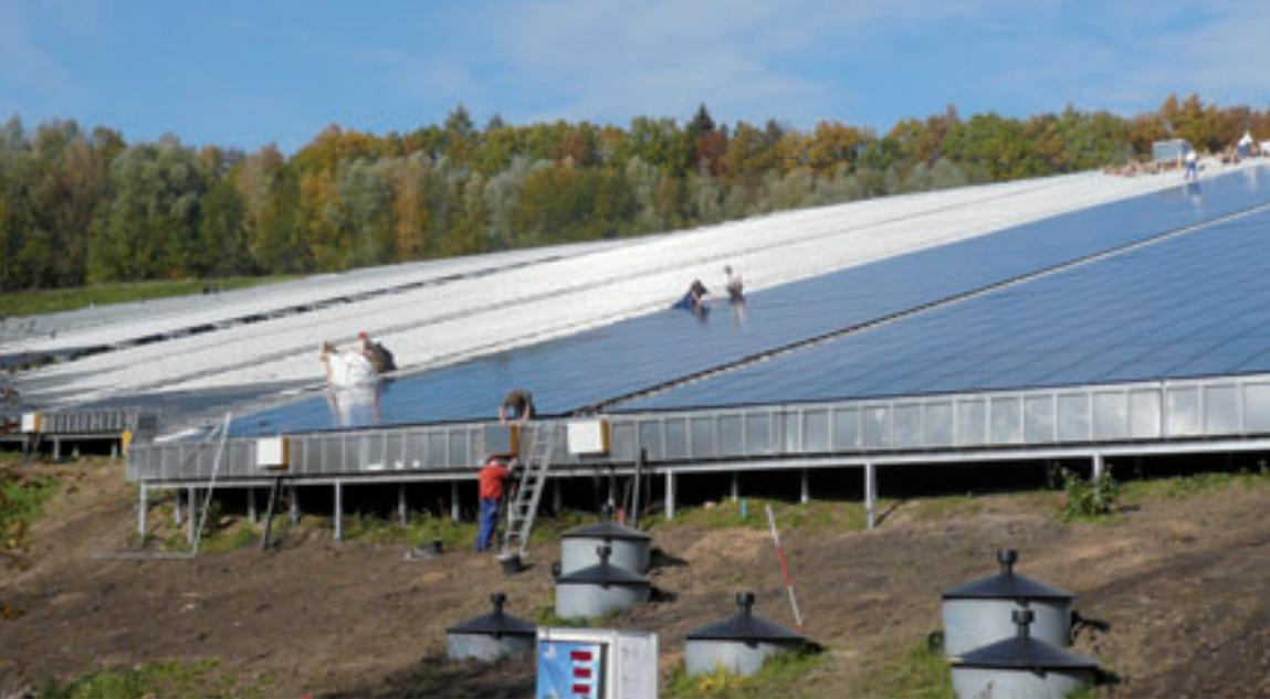
Eine fünf Hektar große Photovoltaikanlage dichtet auf der Deponie Dörentrup bis zum Bau der endgültigen Oberflächenabdichtung den Deponiekörper ab und erzeugt für über 1.000 Haushalte Strom
