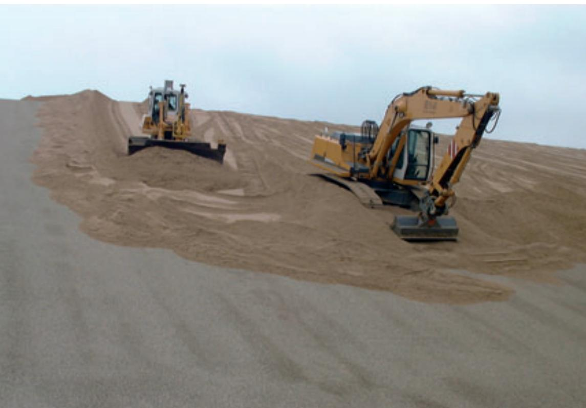
Wird eine Kapillarsperre eingebaut, so lässt der Porengrößenunterschied zwischen der oberen Lage feinen Sandes (Kapillarschicht) und der unteren Lage aus Kies (Kapillarblock) das Niederschlagswasser in der Kapillarschicht ablaufen. Dies verhindert somit das Einsickern in den Deponiekörper.
