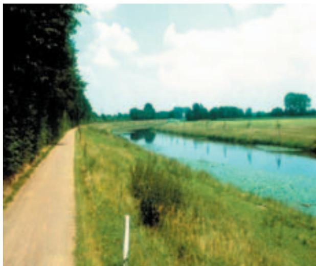
Abb. 196: Nahezu gestreckter Verlauf der Bocholter Aa im Regelprofil
