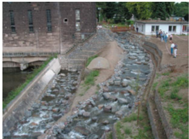
Abb. 104: Fischaufstiegsanlage an der Ruhr (Kraftwerk Raffelberg)
