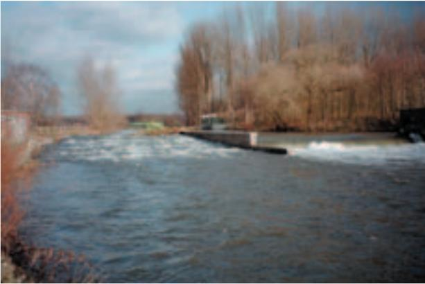
Abb. 57: Wupper am Reuschenberger Wehr. Im linken Bildteil eine neu gestaltete raue Rampe als Fischaufstiegshilfe
