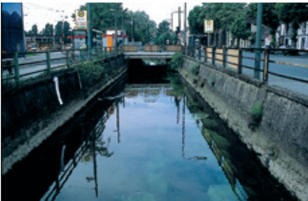
Abb. 18: Eingefasster Abschnitt der Itter im Bereich von Benrath
