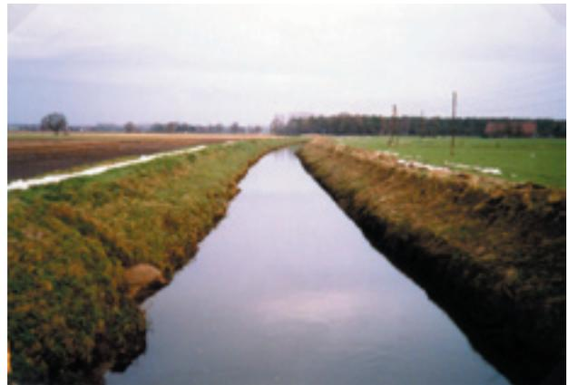
Abb. 194: Überformter Abschnitt der Issel im technischen Regelprofil
