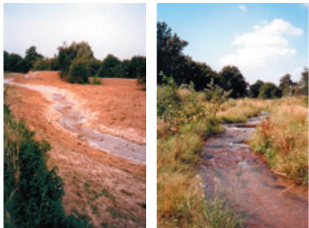
Abb. 28: Umgestalteter Gewässerabschnitt am Rotbach unmittelbar nach Abschluss der Bauarbeiten und ein Jahr danach
