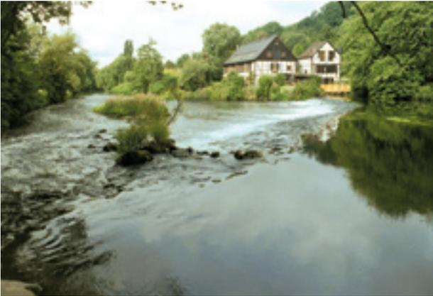
Abb. 213: Raue Rampe ermöglicht die Durchgängigkeit
