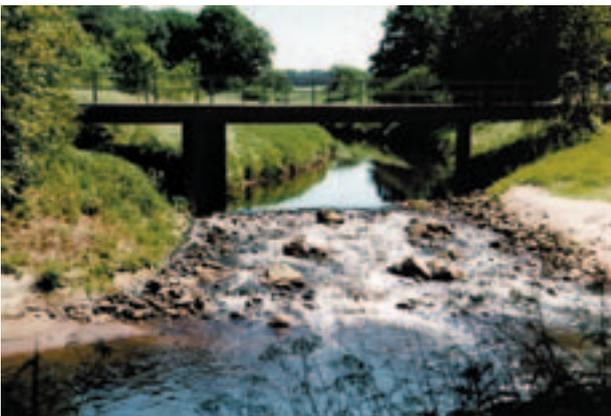
Abb. 142: Umbau eines Sohlabsturzes in eine raue Rampe (Mündung der Hessel in die Ems)
