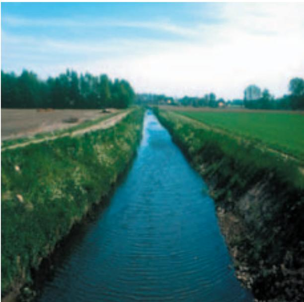
Abb. 200: Tief eingeschnittener und begradigter Abschnitt der Ahauser Aa
