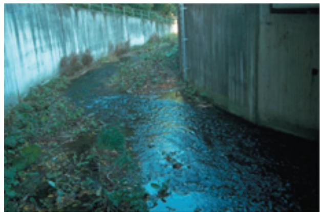
Abb. 77: Als Betonkastenprofil ausgebauter Ruhrabschnitt in Olsberg-Assinghausen
