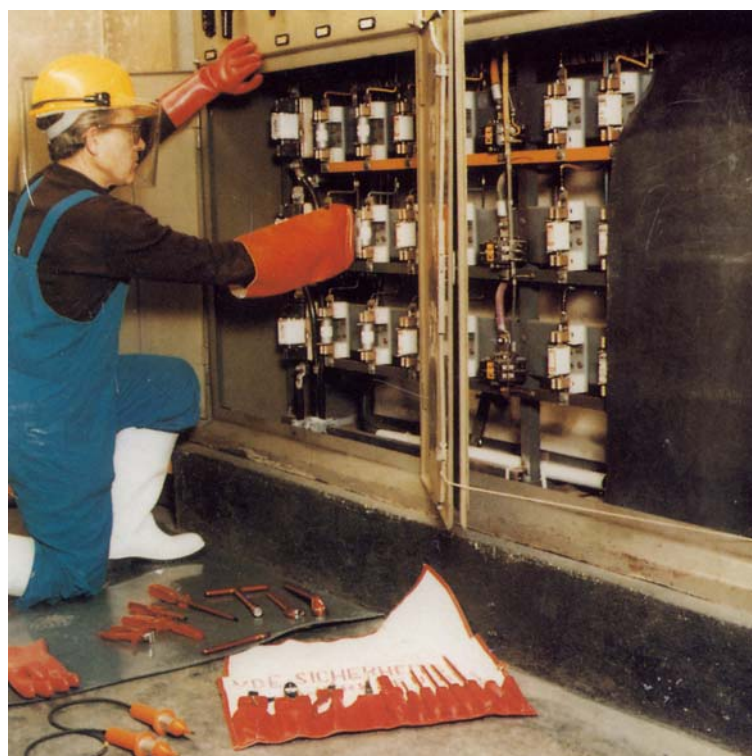
Abb. 5.6: Auswechseln von NH-Sicherungseinsätzen (siehe Anhang)
