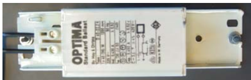
Abb. 10.8: Vorschaltgerät (siehe Anhang)
