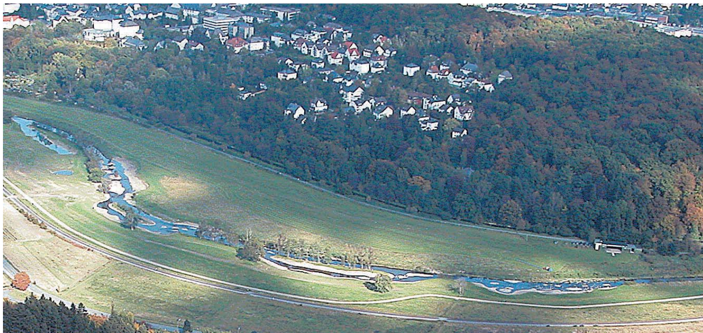
Die Aufweitung des Flussbettes bringt das Gewässer wieder in Kontakt zur Aue.
