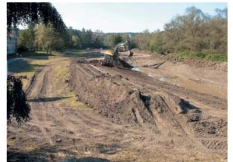
Die Bauarbeiten an Mengen Wiese machen Fortschritte. Das Verzweigungsgerinne wird ausgebaggert.
