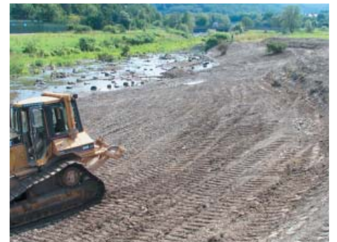
Das Flussbett im „Alten Feld“ wird ver- breitet, die Ufer abgeflacht und der Kon- takt zur Aue hergestellt.
