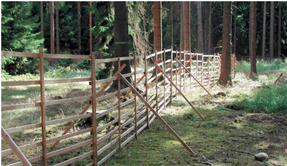
Hordengatter in Holzbauweise.
