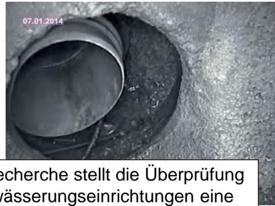
Neben der Nutzungsrecherche stellt die Überprüfung der Grundstücksentwässerungseinrichtungen eine wichtige Grundlage für die orientierenden Untersuchungen dar.
