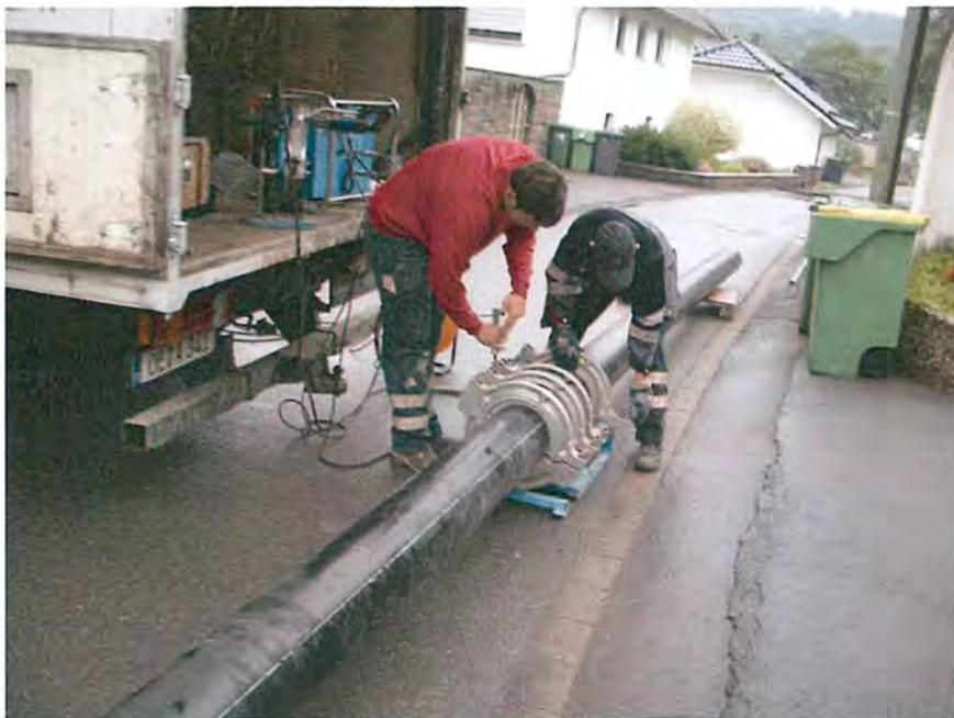
Abbildung 20 Schweißen mit Stumpfelement, Foto, Klapp & Müller
