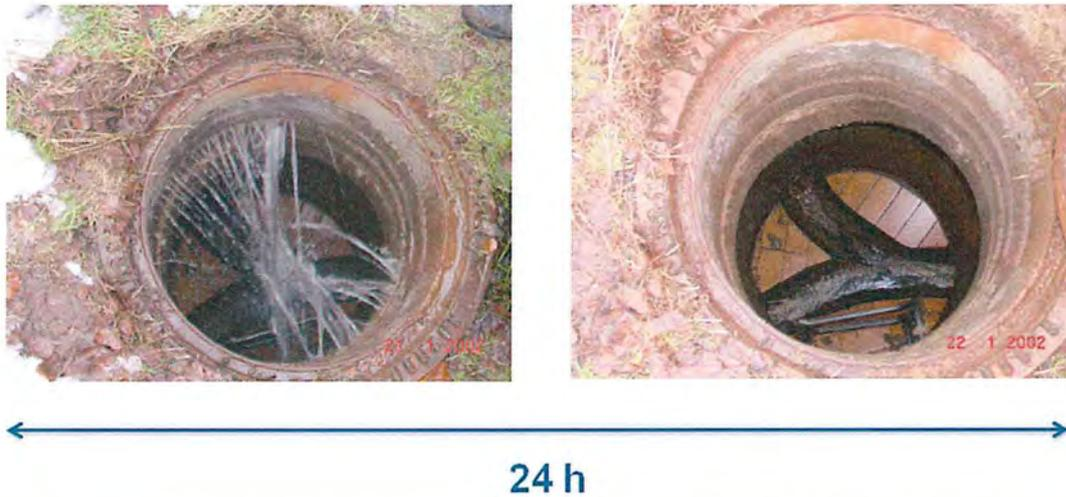
Abbildung 3 Ergebnis einer Schacht-Untersuchung auf FW-Zufluss zweier aufeinanderfolgender Tage während der Schneeschmelze im Jahr 2002. links: Infiltration (spritzend) über Schachtringe am 21.01.02; rechts: derselbe Schacht ein Tag später (22.01.02). Es ist keine Infiltration mehr feststellbar.
