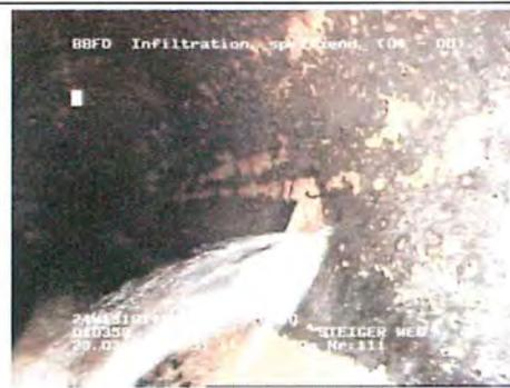
Abbildung 5 Infiltration (spritzend) infolge Scherbenbildung bei einem außergewöhnlichen hydrostatischen Druck.
