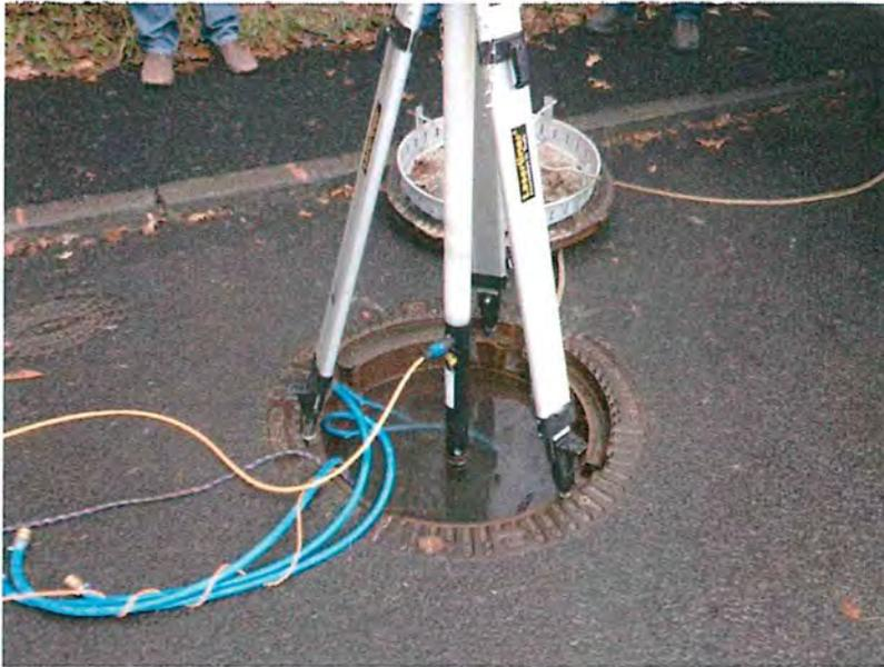
Abbildung 25 Dichtheitsprüfung mit Wasser, Foto, Klapp & Müller
