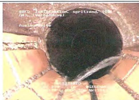
Abbildung 6 Infiltration (spritzend) an der Rohrverbindung eines Schachtes
