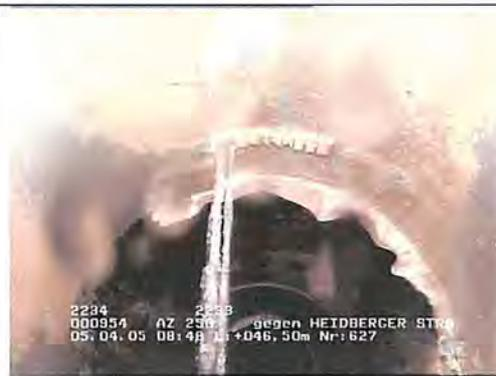
**Abbildung 11** Undichte Edelstahlmanschette
