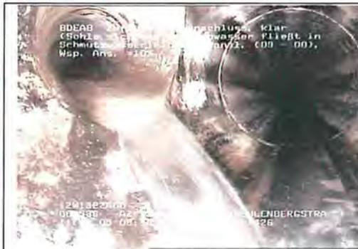
**Abbildung 8** FW-Zufluss über einen seitlichen Anschluss
