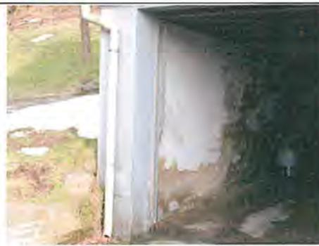
**Abbildung 9** Vernässungsschäden eines Altbaus (Winter 04/05). Die Erstellung eines DW-Konzeptes ist für eine nachhaltige FW-Reduktion im Projektgebiet dringend erforderlich
