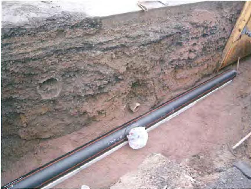
Abbildung 23 Sauberkeit in der Baugrube, Baugrubensicherung und Verlegekissen, Foto Klapp & Müller
