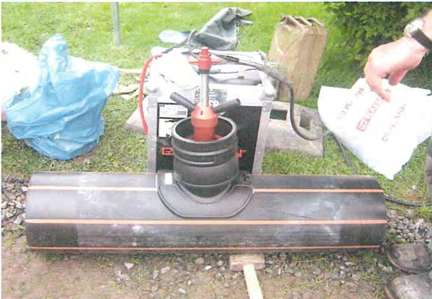
Abbildung 22 Abzweigstutzen aufschweißen, Foto, Klapp & Müller
