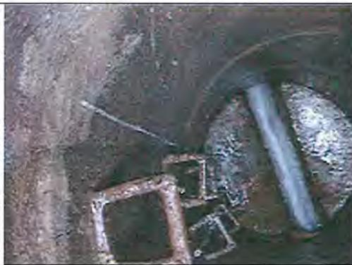
**Abbildung 10** Fremdwasserinfiltration in einen ein Jahr zuvor sanierten Schacht ca. 80 cm unterhalb der Straßenoberkante im Winter 2004/2005.
