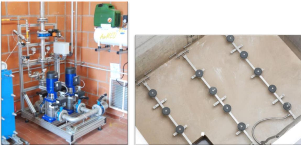
**Abbildung 3-3: Ozon-Eintragssysteme, Injektor (links) und Diffusor (rechts)**
