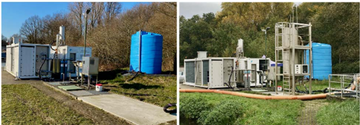
Abbildung 9: Fotos vor (links) und nach Installation des Sandfilters (rechts).
