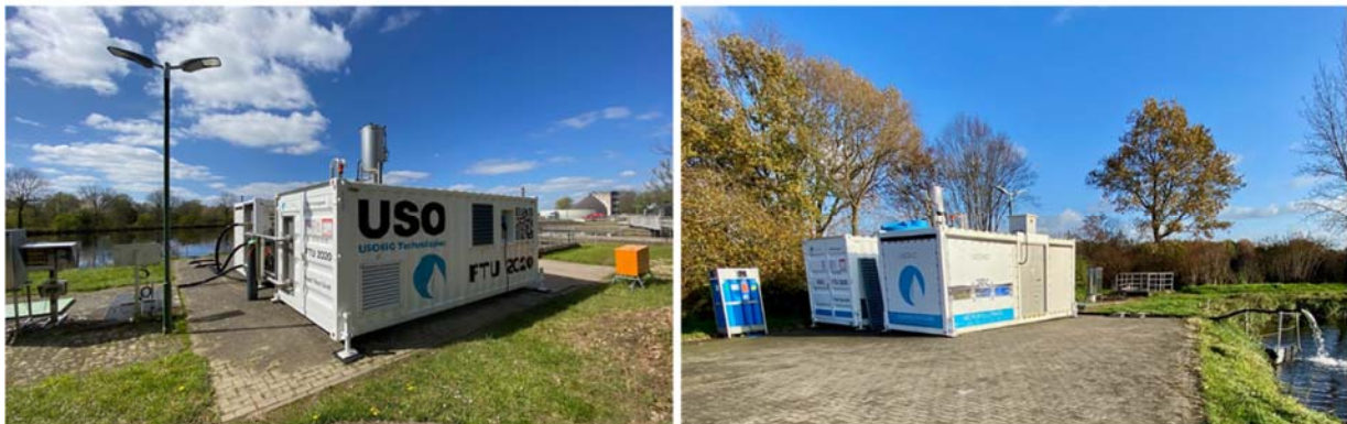
Abbildung 7: Container 1 (links) und Container 2 (rechts) der USO 2020 Pilotanlage der Firma USONiQ, installiert im Ablauf der ZKA Hamminkeln.
